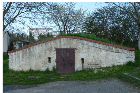
Obr. 29 Horní haltýř jemnického vodovodu, 2009.
