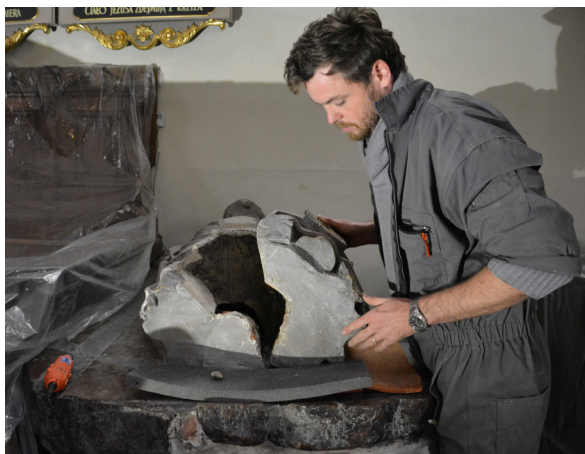
Obr. 3 Demontáž náhrobku. Foto: Univerzita Pardubice, Fakulta restaurování.
