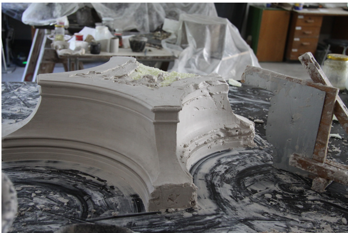
Obr. 9 Architektonické doplňky historizující verze fontány byly nakonec vytvořeny klasickou štukatérskou metodou ze sádry za pomoci šablon. Foto: Pavel Mrověc (2013)
