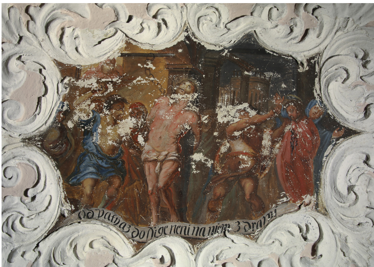
Obr. 6 Celkový pohled na výjev na vítězném oblouku. Stav po očištění depozitů a sejmutí přemalob. Foto: Adéla Škrabalová.
