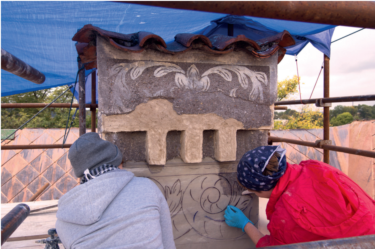
OBR. 10 Průběh práce, rekonstrukce ornamentu. Foto: Daniela Jakubů
