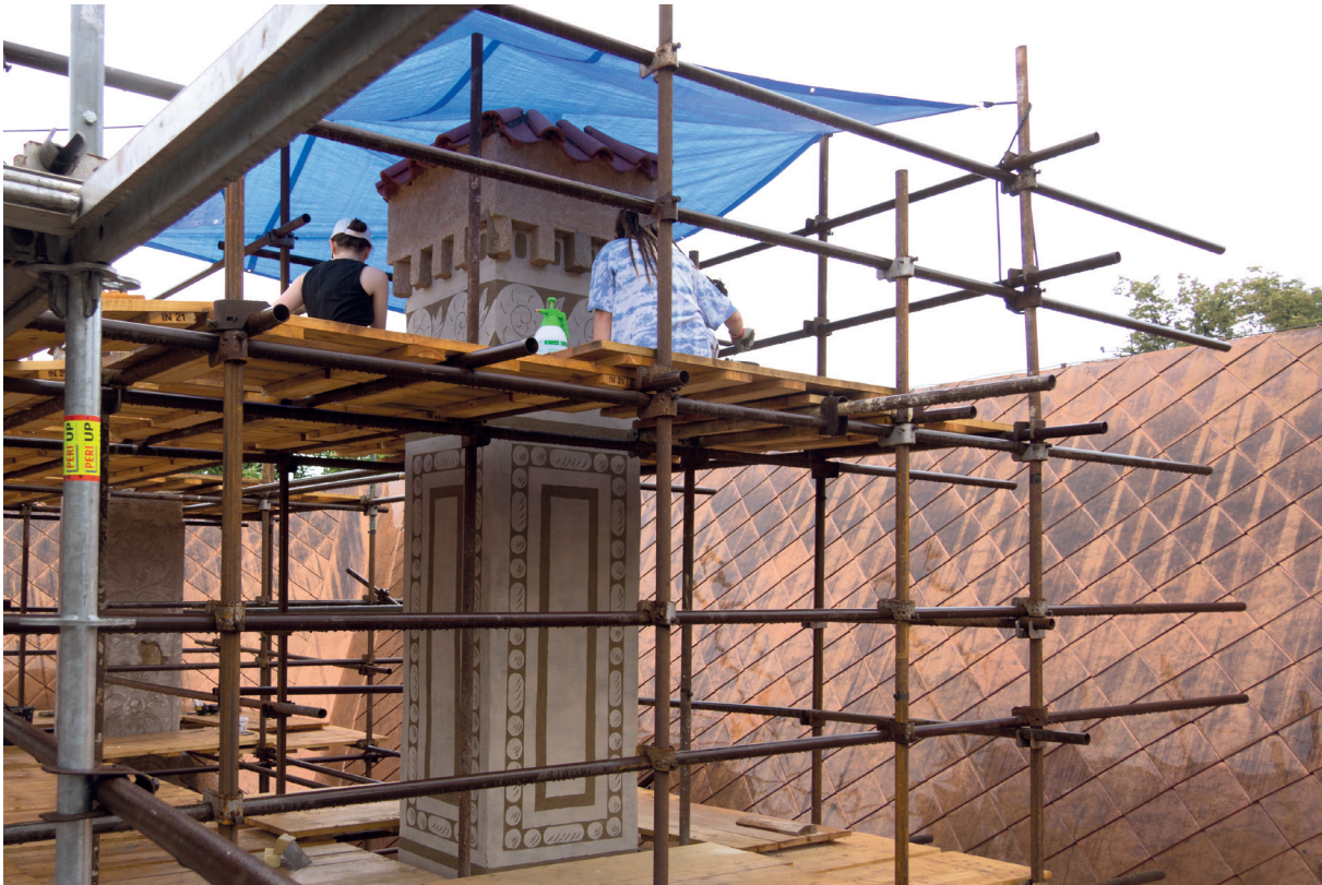
OBR. 11 Průběh práce, rekonstrukce ornamentů na komínu č. 1, v pozadí komín č. 2. Foto: Daniela Jakubů
