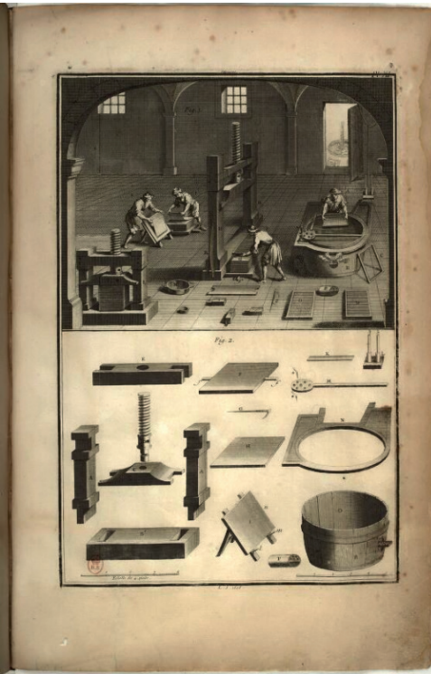
OBR. 2 Odlievanie papiera / Nástroje používané pri odlievaní. Zdroj: Joseph Jérôme Lefrançois de Lalande, Art de faire le papier , Paris 1761.
