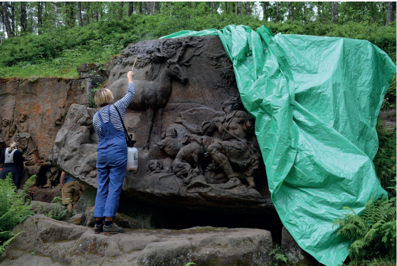
Obr. 5 Plošná aplikace denaturovaným lihem formou postřiku a následné zakrytí plachtou. Foto: Petra Zítková
