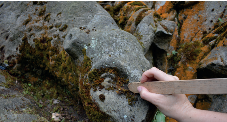
Obr. 2 Snímání vyšší vegetace za pomoci dřevěných špachtlí a kartáčů. Foto: Petra Zítková
