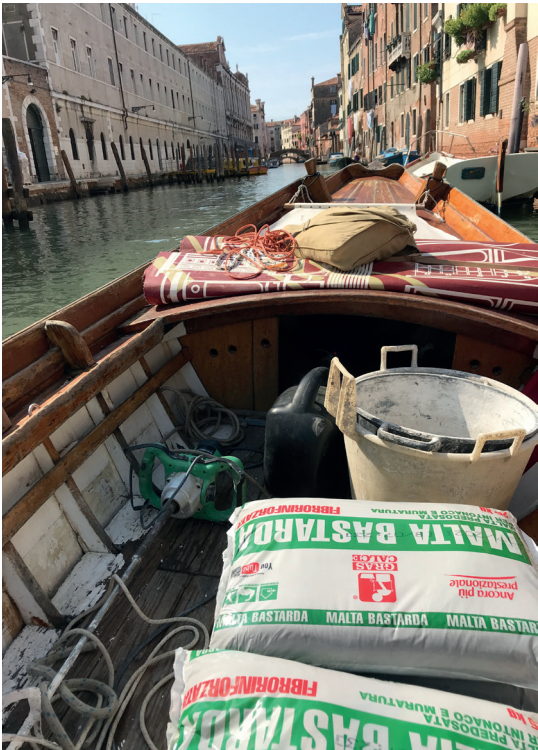
Obr. 2 Přeprava materiálu z obchodu se stavebninami poblíž Chiesa di San Lazzaro dei Mendicanti. Foto: archiv Vojtěcha Mrověce
