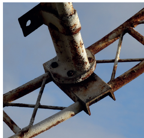
Obr. 20 Otočné spojení příčnicku a vnitřního kruhového nosníku plastiky, 2016. Foto: Pavel Novák
