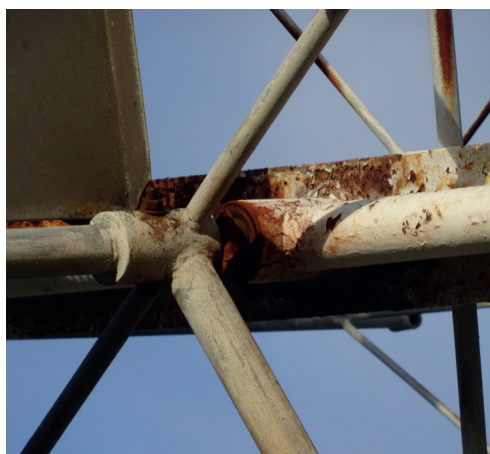
Obr. 21 Ložisko ve středu příčnicku pro otáčení osy vestaveb plastiky, 2016. Foto: Pavel Novák
