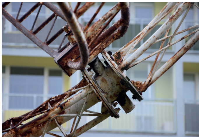
Obr. 19 Dolní mezikus na vnějším kruhovém nosníku umožňující otáčení vnitřního kruhového nosníku plastiky, 2016. Foto: Zuzana Křenková
